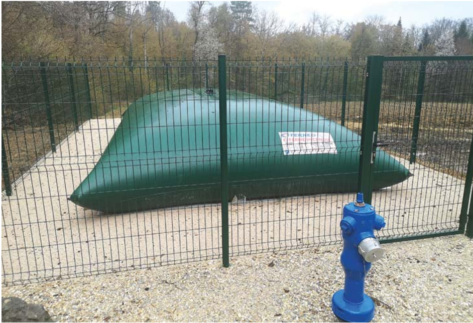
La nouvelle poche à incendie implantée rue d'Étupes.
