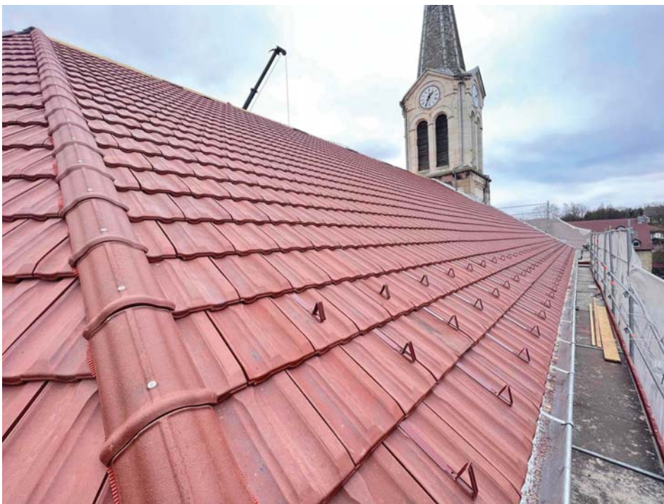
L'entreprise CZE a remplacé la toiture du Temple.
