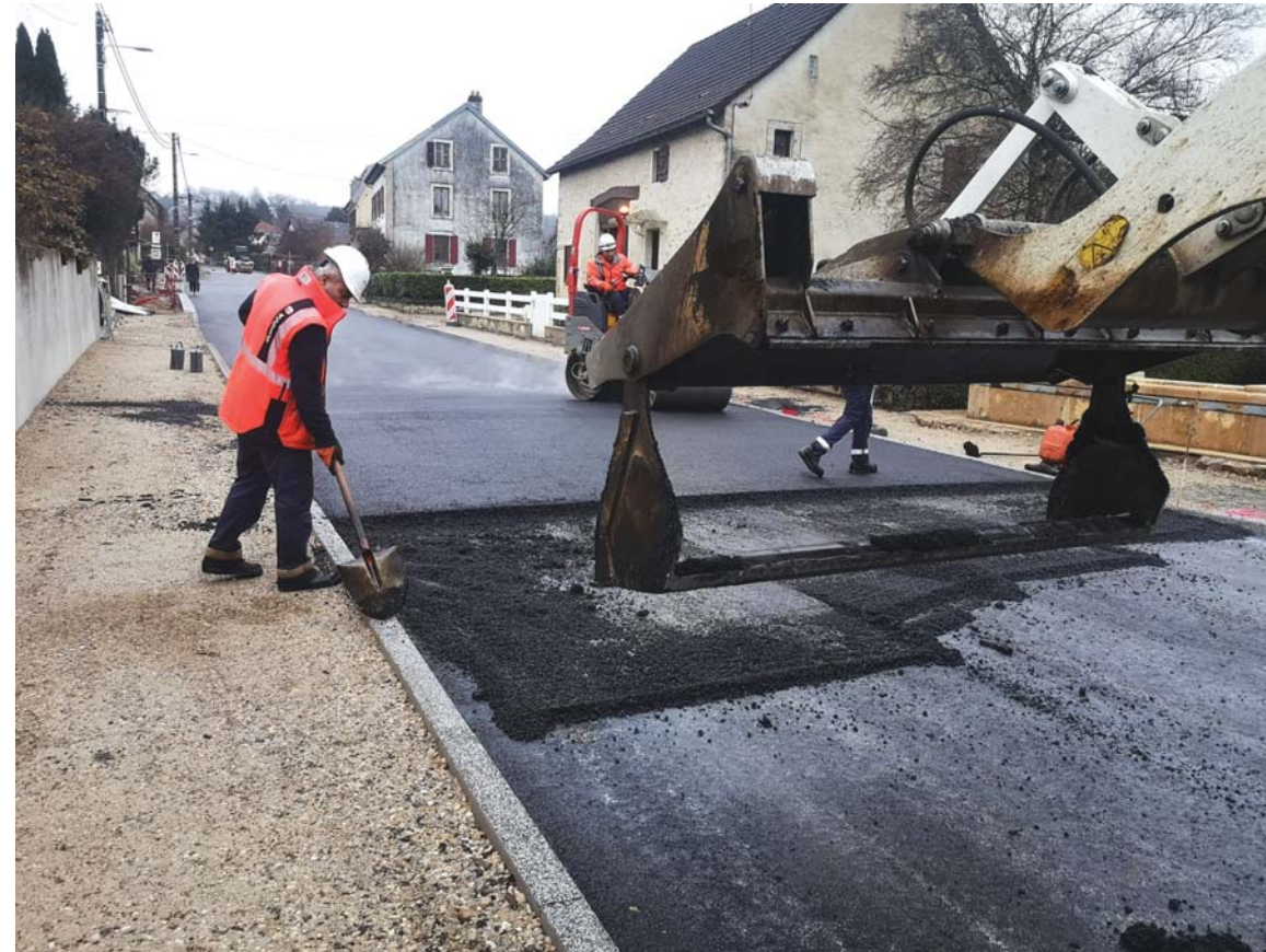
Le 5 décembre, l'entreprise a procédé à la pose de l'enrobé sur le dernier tronçon.
